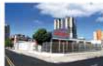
Fundamental Av. Santos Dumont, 3777 (85) 3535.7474
